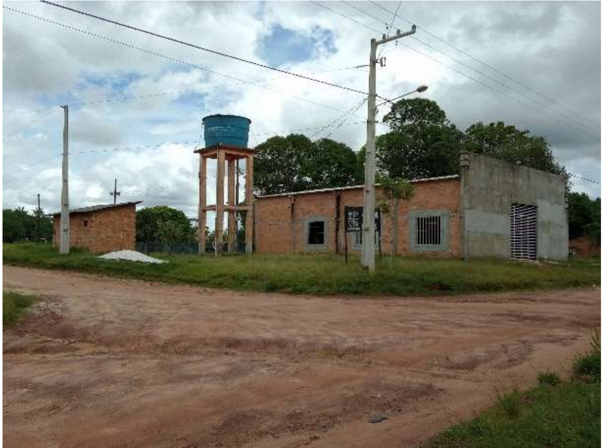
Figura 1.3-4 – Ambiente do Compartimento 4 – Ramal Santa Rita.
