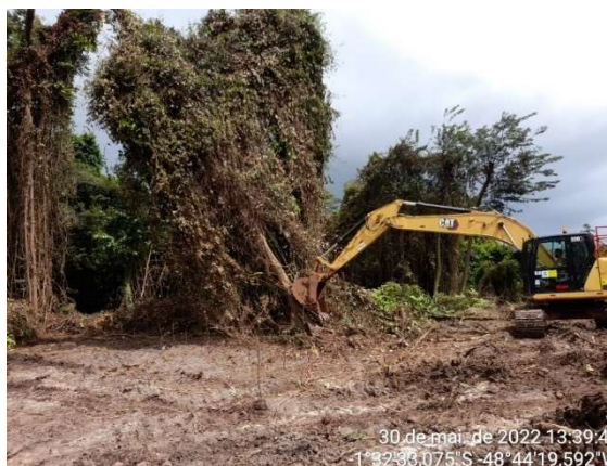
(a) Tombamento da árvore forçado com a lâmina do trator
