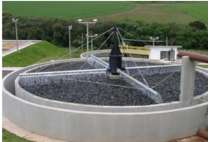
Figura 15 – Filtro Biológico Aeróbio.
