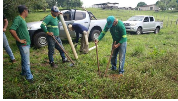
Foto 2: Execução do furo de trado para realizar teste de infiltração no ponto 10, Área 1.
